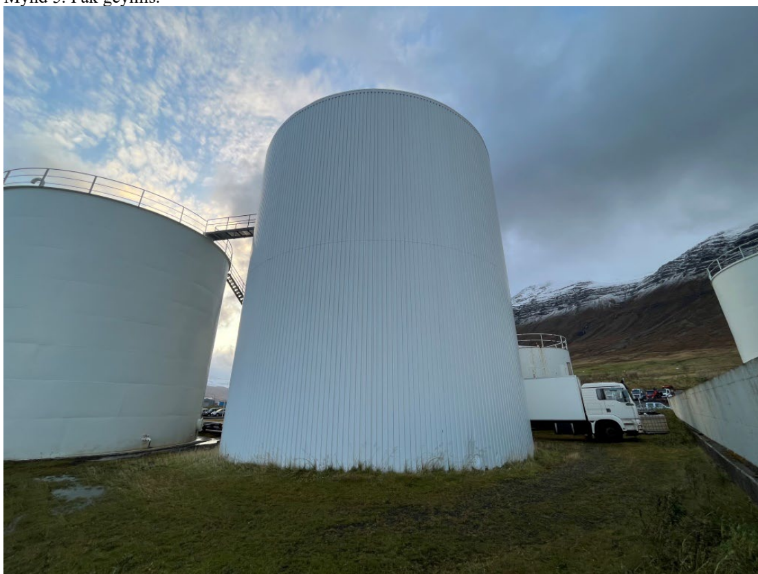
Mynd 6. Geymir er einangraður að utan.
