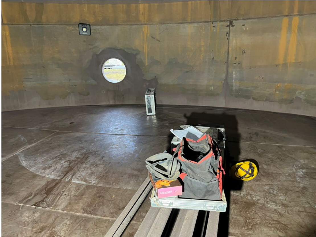
Mynd 1: Mannop geymis. Geymir er málaður að hluta.
